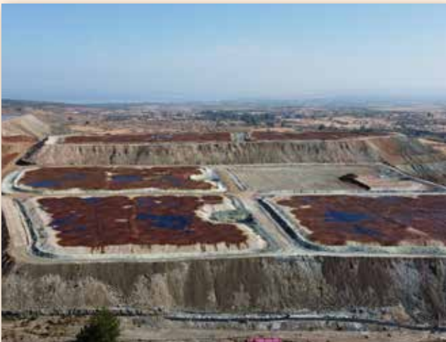
Πλατείες εκχύλισης μεταλλεύματος νικελιούχου λατερίτη
