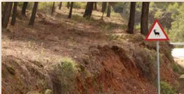
Εφαρμογή Δασοκομικών Μέτρων, κατά μήκος του δρόμου Κάμπου - Πύργου
