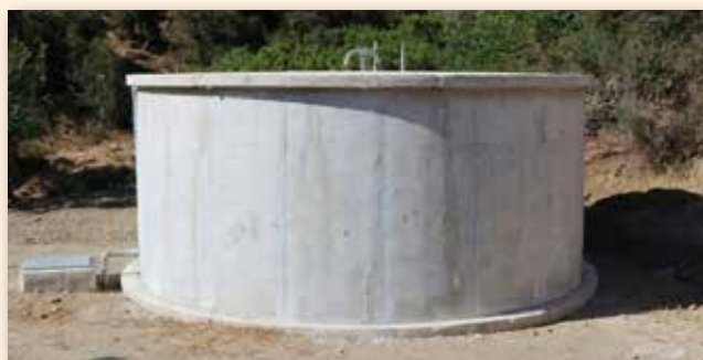
Κατασκευή υδατοδεξαμενής χωρητικότητας 90 m 3 στο Δάσος Ακάμα
